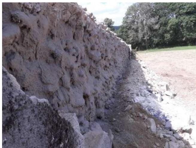
Le mur d'enceinte du côté gauche se partage dans le sens de la longueur et s'écroule sur plusieurs dizaines de mètres.
